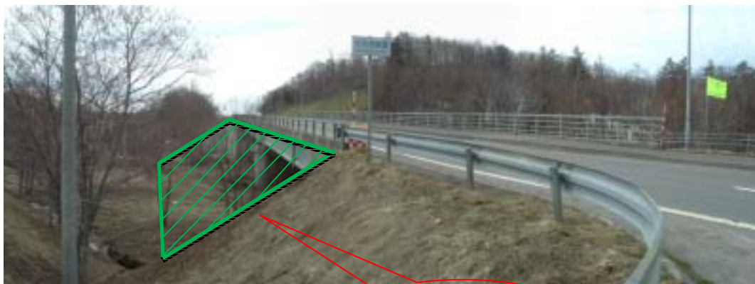
跨線橋解体後、 盛土道路造成
